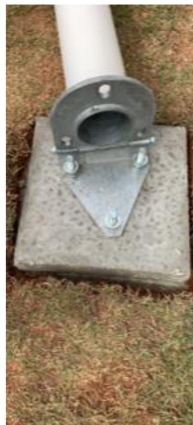
Os mastros em fibra de vidro fixam-se ao solo através de ganchos inseridos em concreto e duas placas na sua base. A base é rebatível, facilitando assim a montagem através de porcas e parafusos que se ajustam facilmente permitindo a posição vertical do mastro.
